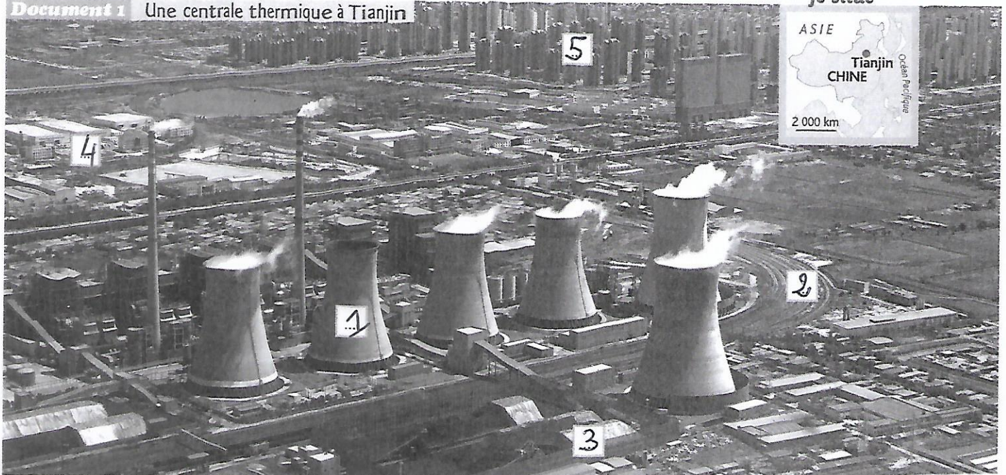
Cette centrale est l'une des nombreuses centrales thermiques fonctionnant au charbon. Elle assure la production d'électricité nécessaire aux régions industrielles et urbaines. L'utilisation du charbon accentue la pollution.
